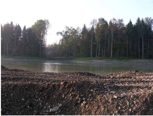
Thurlauf: Kiesumlagerungsarbeiten bei der Flussaufweitung Farhau, neu aktivierter Seitenarm, Blick vom Gegenufer. Thurlauf: Kiesumlagerungsarbeiten bei der Flussaufweitung Farhau, neu aktivierter Seitenarm, Blick flussaufwärts.
