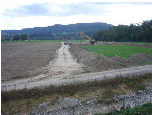
Schüttungsarbeiten im Flaacherfeld, Feld Ritzmann: Einsatz von sog. Baggermatratzen zum Bodenschutz. Pumpwerk Forspitz: Baugrube
