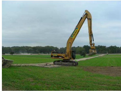
Weierbau mit Grundwasseranschluss im Wald, linksufrig, unterhalb der Flussaufweitung Farhau. Schüttungsarbeiten im Flaacherfeld, Feld Ritzmann: Einsatz von Grossbagger mit 17 m Armlänge.
