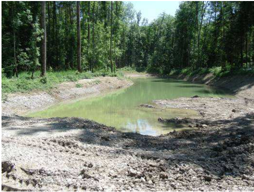
Weierbau mit Grundwasseranschluss im Wald, linksufrig, unterhalb der Flussaufweitung Farhau. Schüttungsarbeiten im Flaacherfeld, Feld Ritzmann: Einsatz von Grossbagger mit 17 m Armlänge.
