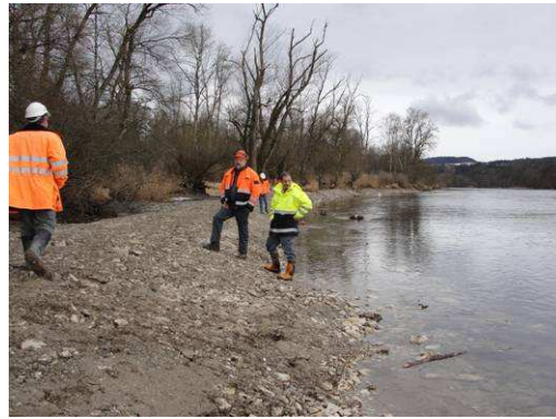
Abbruch vom alten Uferschutz (links, Blick rheinaufwärts) am Rhein oberhalb vom Thurspitz: Der Fluss darf den Kiesufer erodieren (rechts, Blick rheinabwärts).
