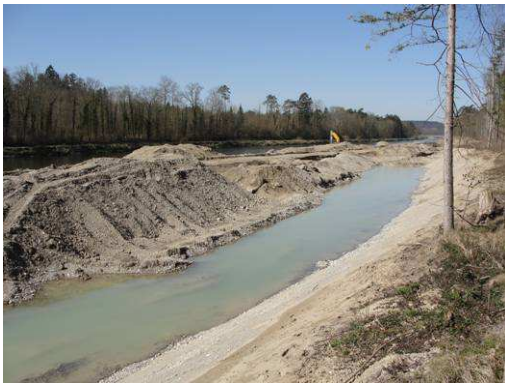
Baggerungsarbeiten zur Flussaufweitung oberhalb der Ellikerbrücke: Links Blick flussabwärts aus dem Waldrand betrachtet, rechts aus dem Flusslauf betrachtet.
