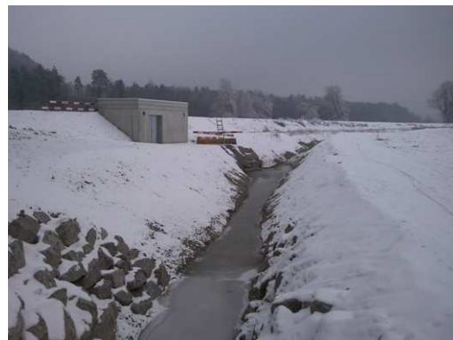
... und entlang dem Rhein, inklusive Neugestaltung der Hohlenrütigraben, der zur Entwässerung des Flaacherfeldes und zur geordneten Abführung des Sickerwassers entlang dem Damm dient. Baugrube des Pumpwerks zum Ableiten des entwässerten Wassers in den Rhein.
