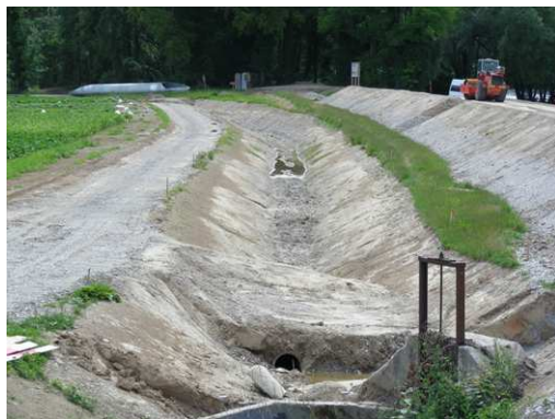
... und entlang dem Rhein, inklusive Neugestaltung der Hohlenrütigraben, der zur Entwässerung des Flaacherfeldes und zur geordneten Abführung des Sickerwassers entlang dem Damm dient. Baugrube des Pumpwerks zum Ableiten des entwässerten Wassers in den Rhein.
