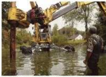
Neue Platte sichern die Überbrückung für die nächsten 100 Jahre. Bild: AWEL
