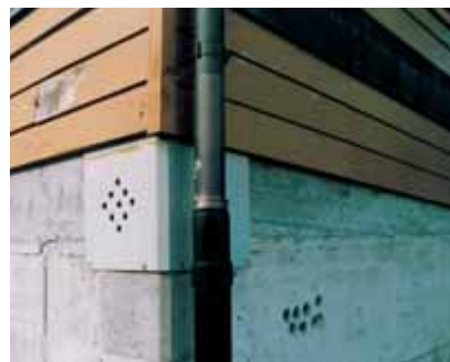
Verdeckte Aussparung für hydraulische Presse
