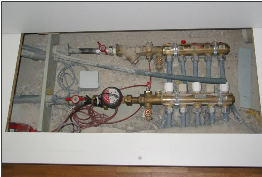
Figur 23: Bodenheizungsverteiler
