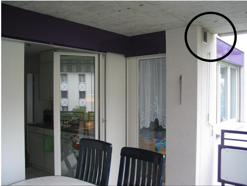
Figur 17: Fortluftgitter Küchenabluft
