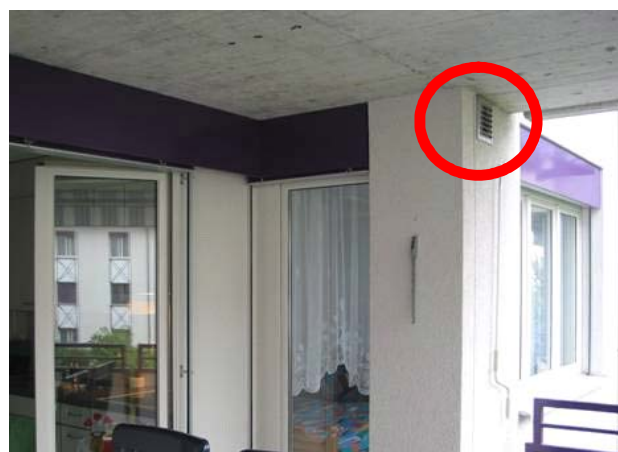
Figur 10: Küchenabluft kann je nach Wind in das eigene Fenster oder ans Fenster der Nachbarwohnung gelangen.
