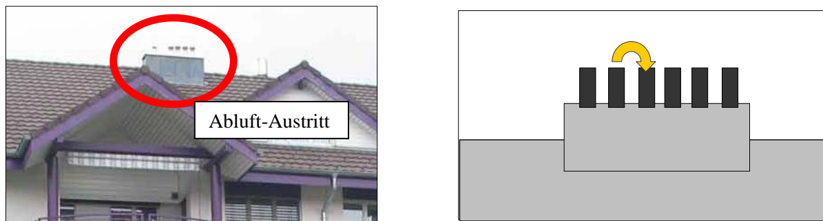
Figur 25: Mündung der Bad-Abluft auf dem Dach
