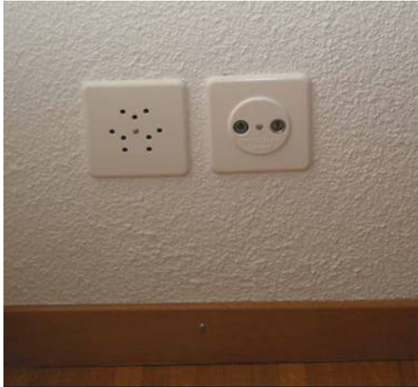
Figur 19: Steckdose und Anschlussdose Kabelfernsehen
