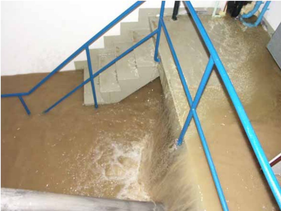
Bild 3: Untergeschoss wird unter Wasser gesetzt
