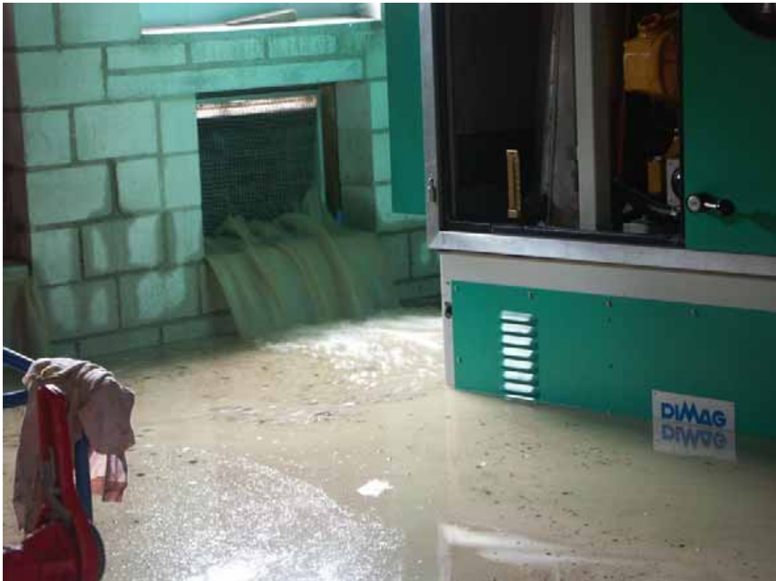
Bild 5: Gasmotor wird unter Wasser gesetzt
