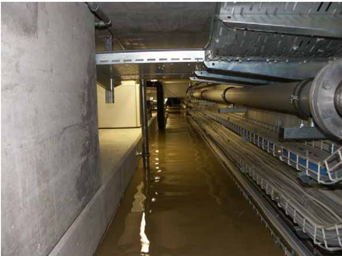
Bild 4: Überfluteter Werkleitungsgang
