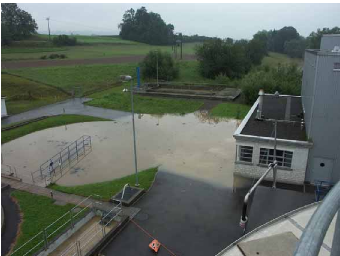
Bild 6: In Folge Rückstau wird Vorklärbeckeninhalt ausgeschwemmt
