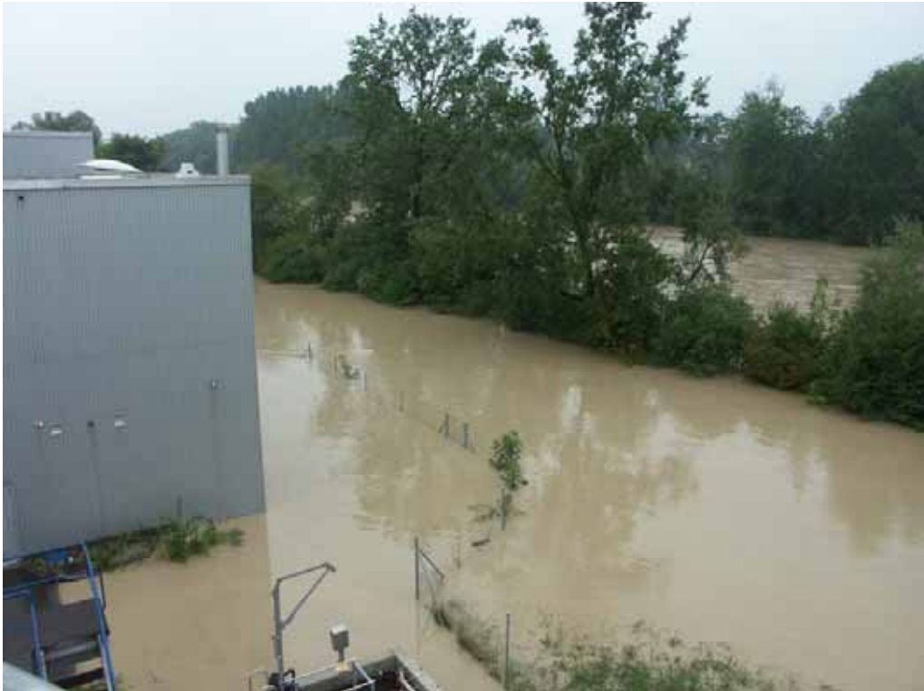
Bild 1: Überflutetes Gelände zwischen Betriebsgebäude und Reuss
