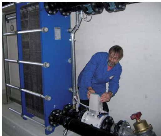
Abbildung 5/6: Die ARA Meilen versorgt umliegende Wärmeabnehmer schon seit mehreren Jahrzehnten mit Abwasserwärme. Sie liefert sowohl kalte Fernwärme (Wärmetauscher, Abbildung links) als auch warme Fernwärme (Wärmepumpe, Abbildung rechts). Planung, Finanzierung, Bau und Betrieb der erforderlichen Anlagen erfolgen durch einen Contractor, in diesem Fall durch die Elektrizitätswerke des Kantons Zürich (EKZ), welche die Kunden mit Wärme versorgen. Die ARA Meilen stellt die Abwasserwärme (gereinigtes Abwasser) und die Räumlichkeiten für die Infrastruktur zur Verfügung.
