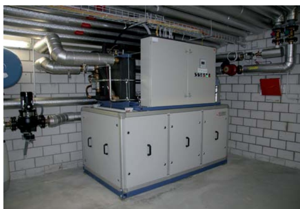
Abbildung 11/12: In der Sportanlage Heerenschürli, Zürich, wird das Abwasser «inhaus» zur Wärmerückgewinnung genutzt. Abbildung links: Einbau des Wärmetauschers; Abbildung rechts: Wärmepumpe und Steuereinheit im ersten Stockwerk der Sportanlage (FEKA Energiesysteme AG, Bad Ragaz)
