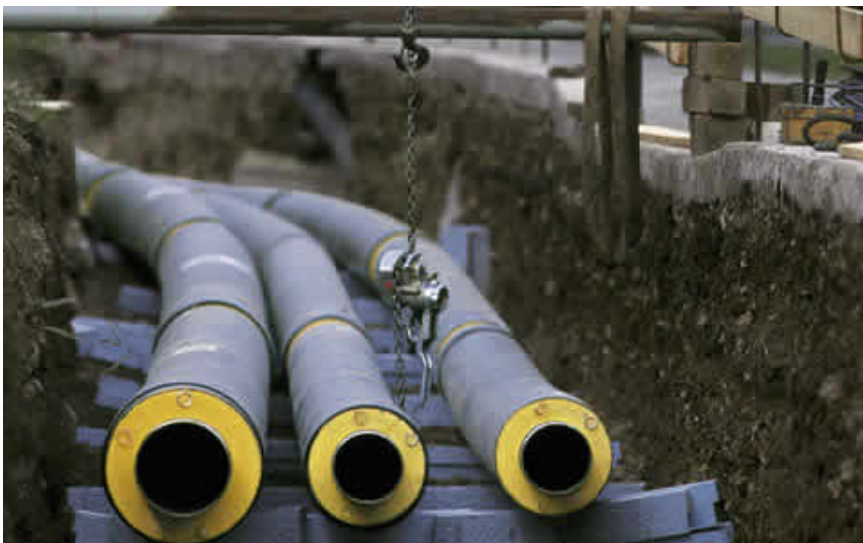
Verlegung von Fernwärmeleitungen.
