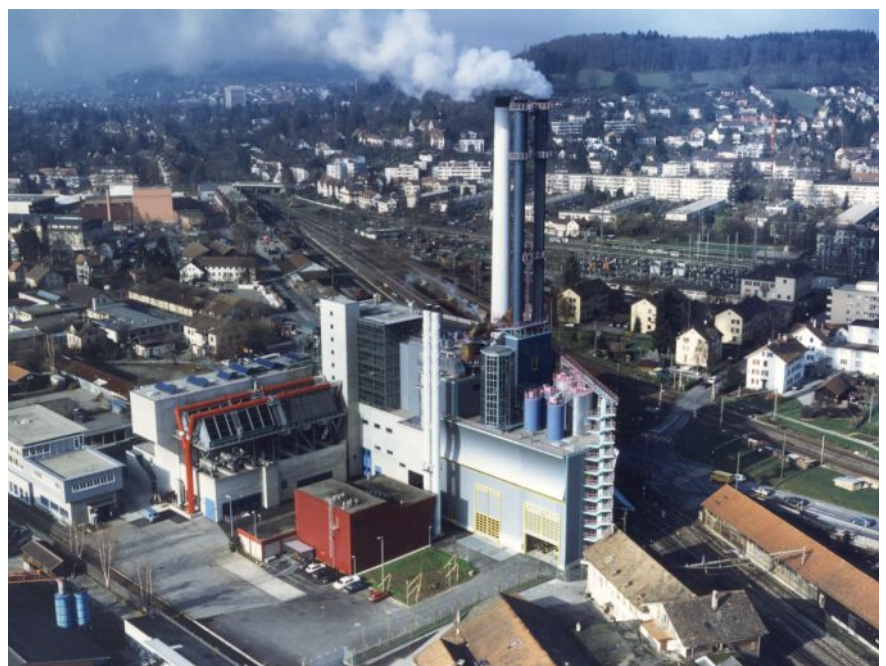
Die Abwärme der Kehrichtverbrennungsanlage Winterthur speist die Städtische Fernwärme.
