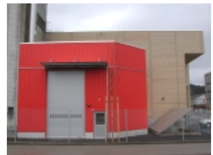
Die Holzschnitzelheizzentrale „Im Gern“, angebaut an das Gebäude eines Holzbaubetriebs. (StWW)
