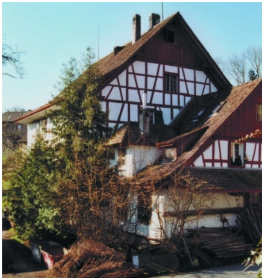
Hirsmühle, Regensberg: Denkmalgeschützte Gebäudesanierung nach Minergie-Standard (vgl. folgende Seite)
