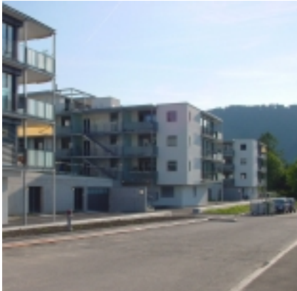
Erdwärmenutzung für 5 Mehrfamilienhäuser mit 64 Wohnungen in Adliswil.
